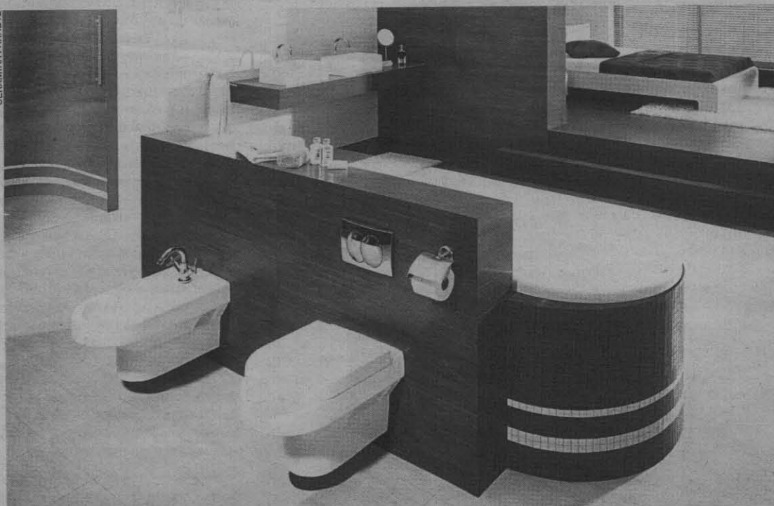
Wanna, w.c. i bidet pośrodku łazienki. Niska ścianka między nimi przesłania urządzenia i chowa instalacje
